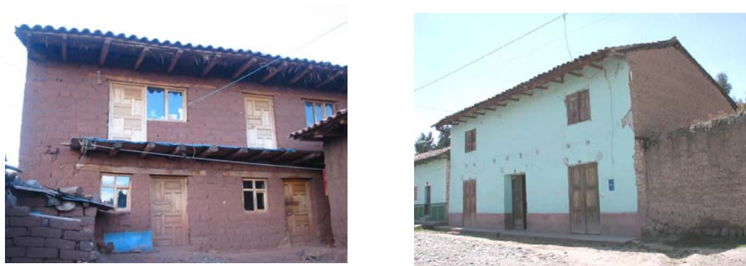
Fig. 1 Viviendas representativas de adobe (Cusco) (izq) y de tapial de dos pisos (Junín) (der.)
