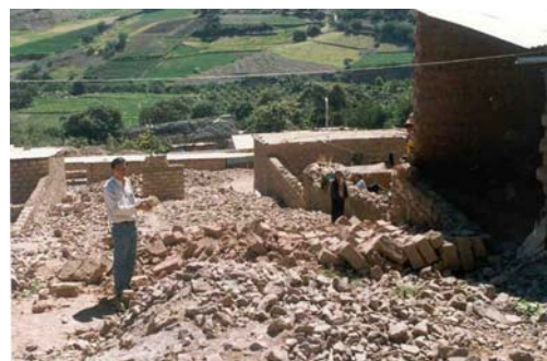
Fig. 5 Falla por volteo (izq.) Colapso de muro por volteo (der.)
