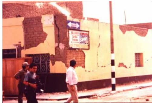
Fig. 3 Falla por flexión en las esquinas (izq.) Vivienda con fallas de flexión (der.) (San Bartolomé, 2002)
