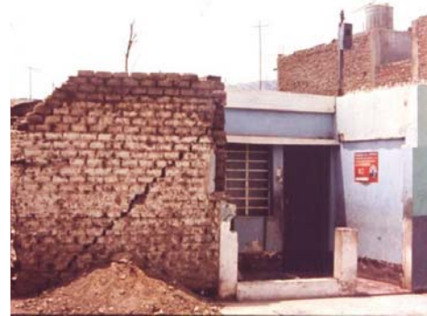
Fig. 4 Falla por corte (izq.). Daño registrado en una vivienda (der.)
